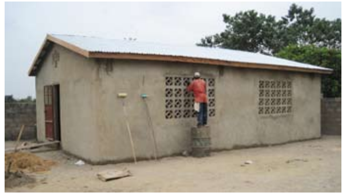
Het nieuwe lokaal in aanbouw
